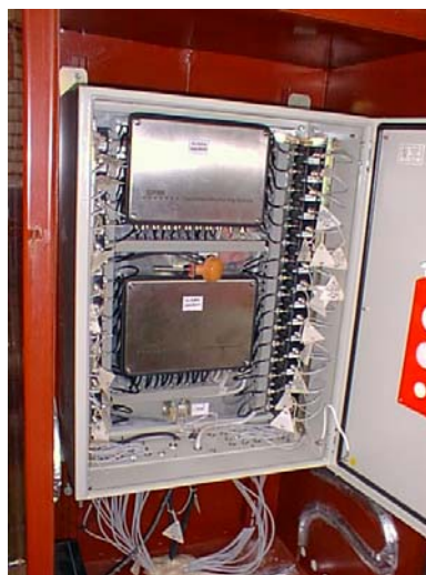
Рис. 10. Пример монтажа барьеров и измерительных блоков внутри обогреваемых шкафов.
