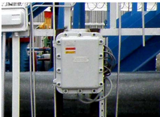
Рис. 9. Взрывозащищенные шкафы.
